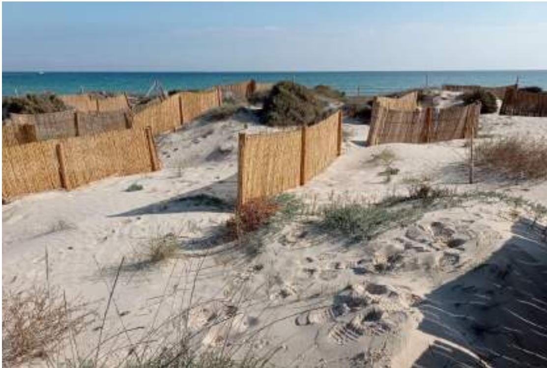
Figura 54. Captadores de arena en la playa de las Salinas de San Pedro del Pinatar. LIFE Salinas.
