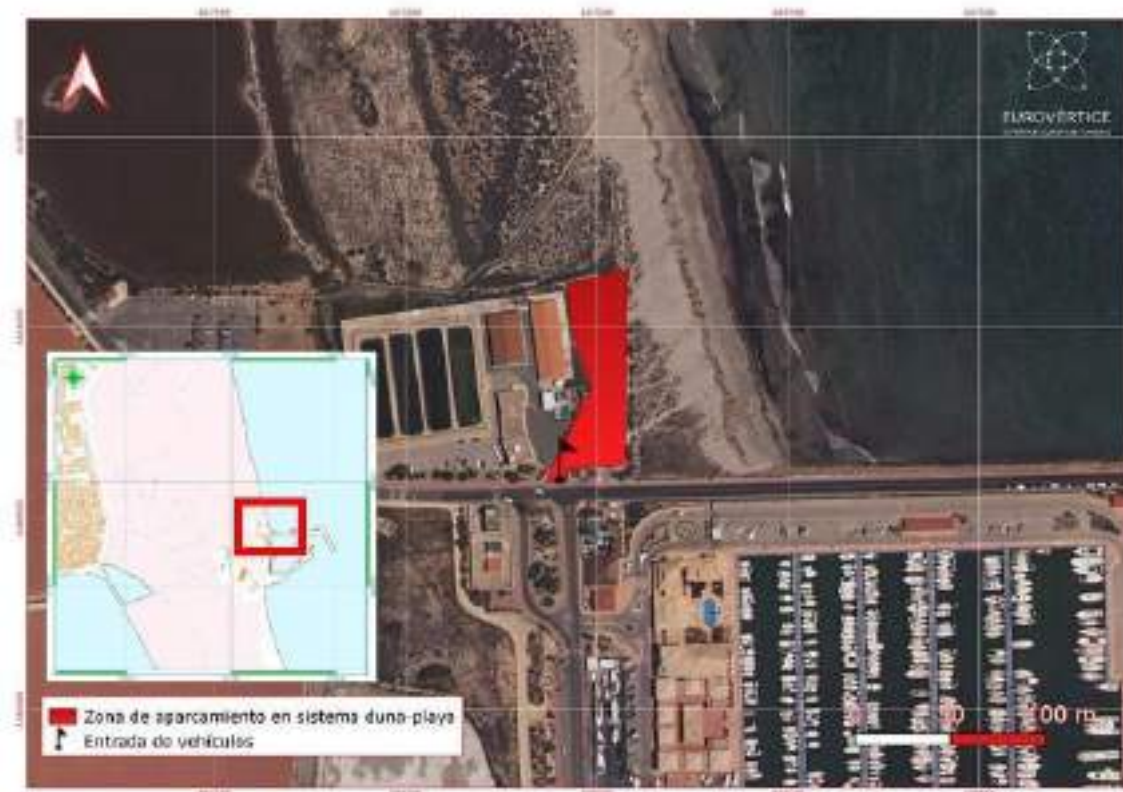
Figura 53. Parking no regulado en la playa de la Torre Derribada. EuroVértice.
